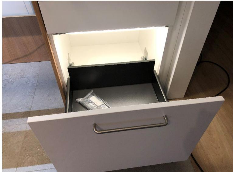
Abbildung 126: sensorgesteuerte Möbelbeleuchtung in der Küche - li.: Lichtband im Oberschrank L05.2.1; re.: Lichtband in Schublade L05.3; detaillierte Informationen zu den Leuchten befinden sich in den Leuchtenbüchern im Anhang
