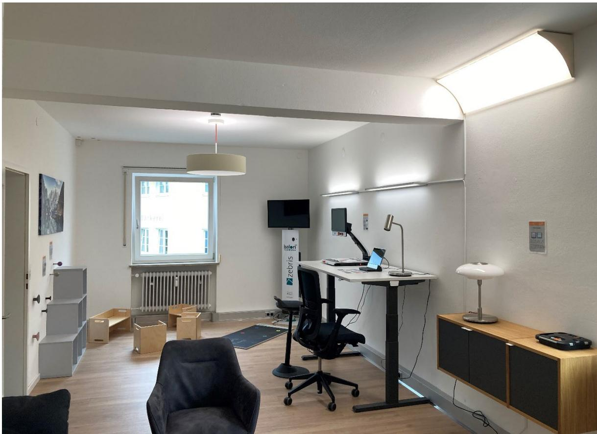
Abbildung 122: Wohnzimmer, Leuchten für Workshop mit Probanden-Befragungen (von li. nach re.: Pendelleuchte L01.3.2, Wandfluter L02.3, Hohlkehle L02.2); detaillierte Informationen zu den Leuchten befinden sich in den Leuchtenbüchern im Anhang
