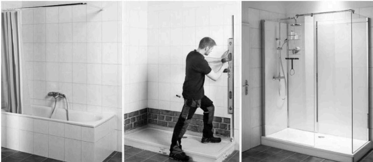
Abbildung 11: Ersatz Einbauwanne durch "bodengleiche" Dusche
