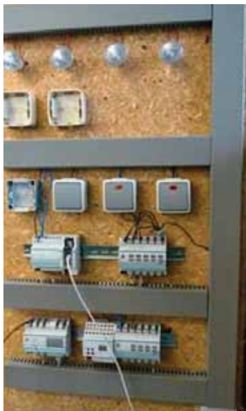
Abbildung 2: KNX Steuergeräte und Halogen-Leuchten
