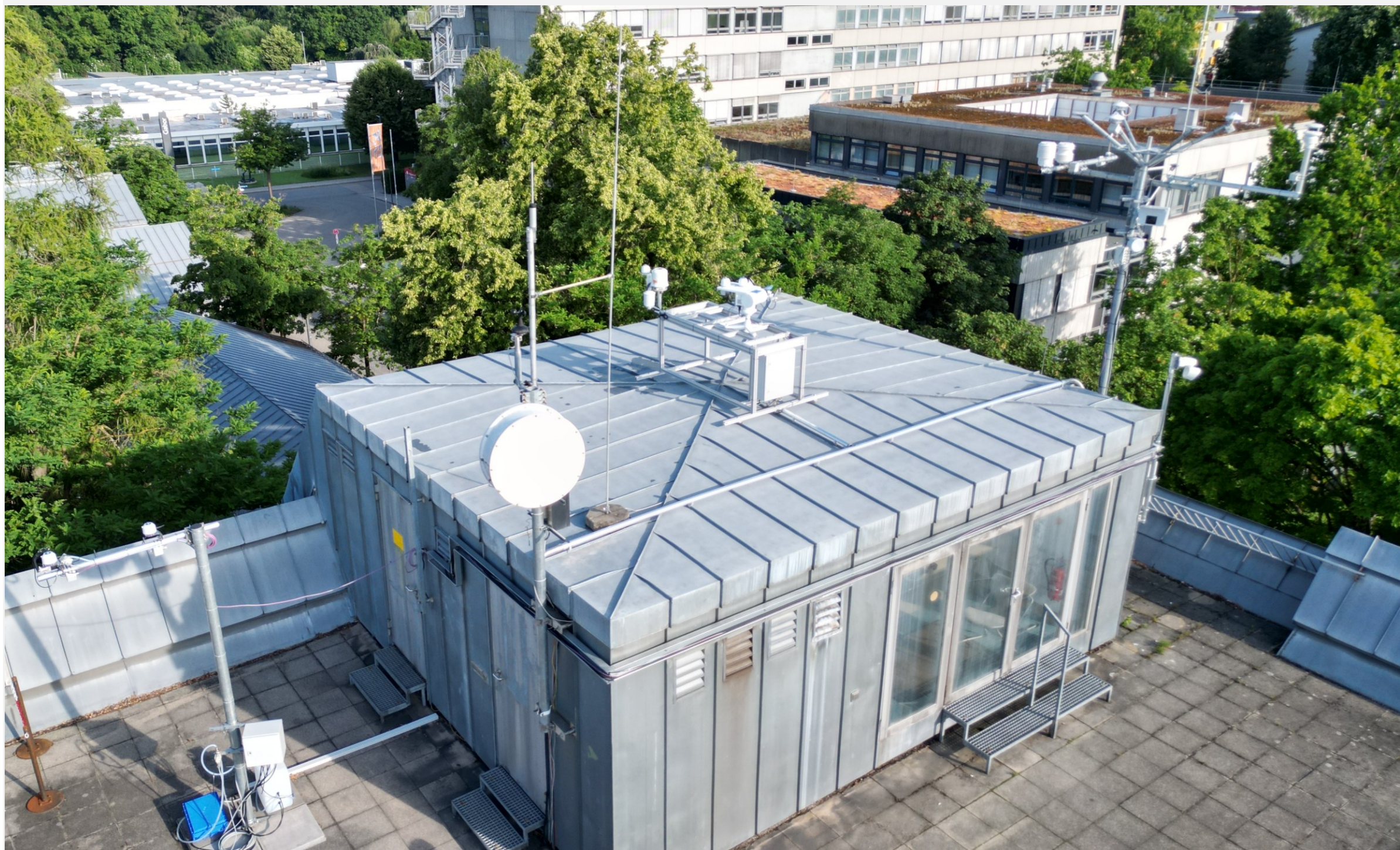
Drohnenaufnahme Wetterstation TH-Rosenheim
