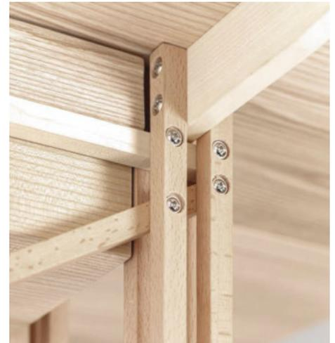
/ Die Kreuzungspunkte der Stabkonstruktion sind durch Schrauben verbunden.
