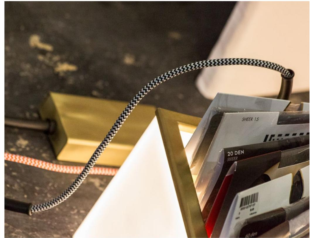
Die Ausgestaltung der Leuchtboxen zeigt gut überlegte Details: Die Stromzuführung erfolgt über textilmantelte Kabel, die mit ihrer Fischgrät-Optik einen sinnfälligen Verweis auf die Ware Strumpf darstellen. Das Kabel selbst trägt Strumpf. Die Stromunterverteilung im Lichtcontainer erfolgt unter einem vierseitigen Abdeckrahmen aus gebürsteten und auf Gehung verlöteten U-Profilen aus Messing.
