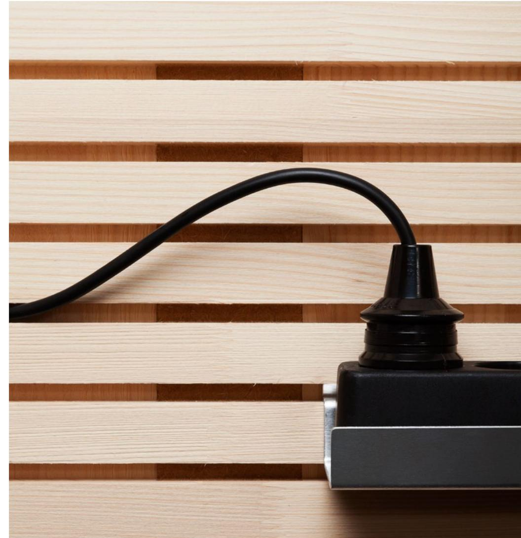
Eine Schale aus Stahlblech wird in die Wand eingehängt und dient als Aufnahme für eine handelsübliche Mehrfachsteckdose. Das Anschlusskabel eines Gerätes wird in eine Fuge des Wandpanels eingelegt und über den Stecker mit der Mehrfachsteckdose verbunden. Die Anzahl, Höhe und Lage der Elemente sind vom Benutzer dabei frei wählbar.
