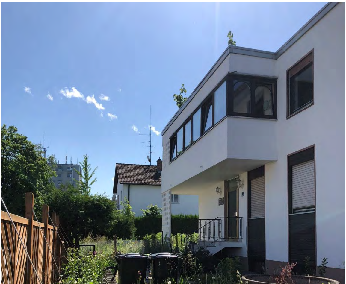
Abbildung 11: Ratiborerstr. 1f - Bestand Südseite Eingang Praxis
