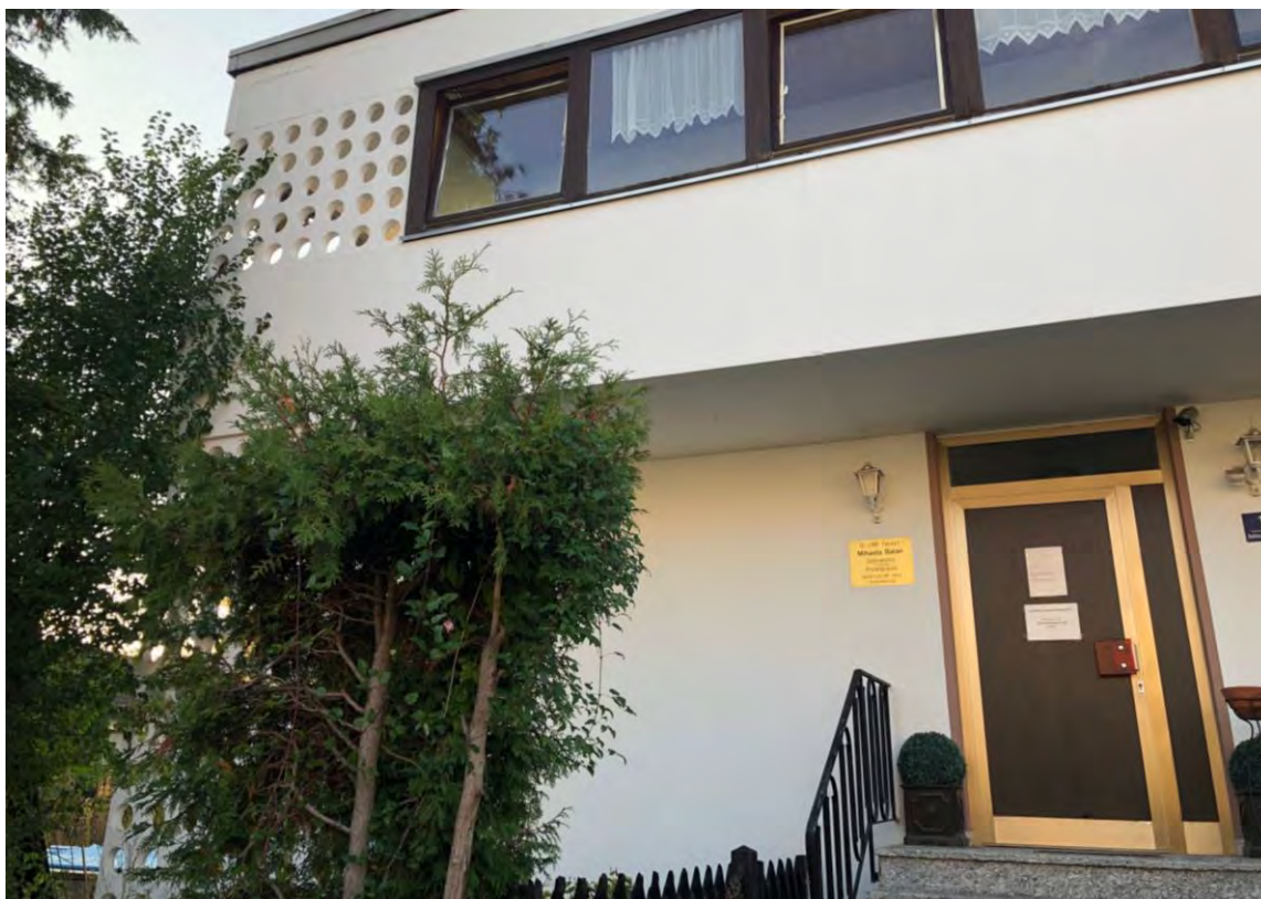
Abbildung 12: Ratiborerstr. 1f - Bestand Eingang Praxis
