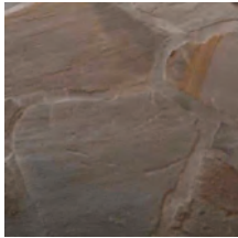
Restaurieren vom bestehenden Steinboden
