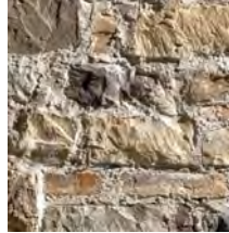
Vordere Wand, seitliche Wände und das Tonnendach aus Naturstein
