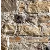
Stein Fassade mit Tonnendach
