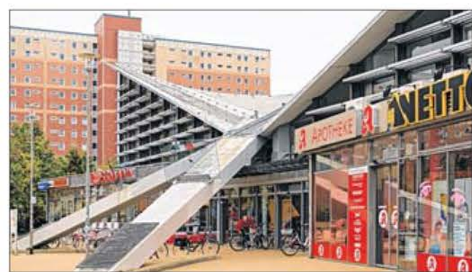
In Rostock sind in einem von Architekt Ulrich Müther geschaffenen Bau Waren des täglichen Bedarfs erhältlich. Foto: Ralf Kozica
