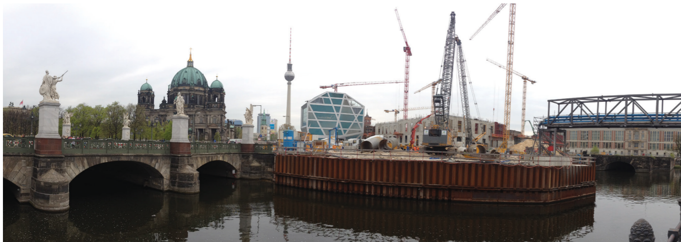
Blick von Bauakademie auf Berliner Dom, Humboldt Box und Schlossbaustelle
