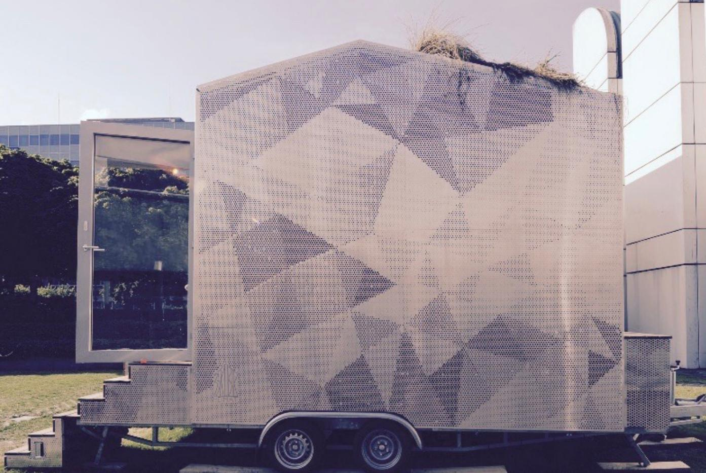
Der Wunsch eine transluzente Wand zu integrieren wurde bei dem ersten Treffen mit Johannes Schelle, Inhaber der Firma Baumbaron, noch gefestigt. Das ausgewählte Material Rodeca ist transluzent und bietet so Sichtschutz, trotz maximalen Lichteinfalls. Die Dämmwirkung des Rodeca-Materials steht den Holzrahmenwänden in nichts nach. Ein interessanter Materialsprung von klassischem Holz zu futuristischem Rodeca entsteht.
