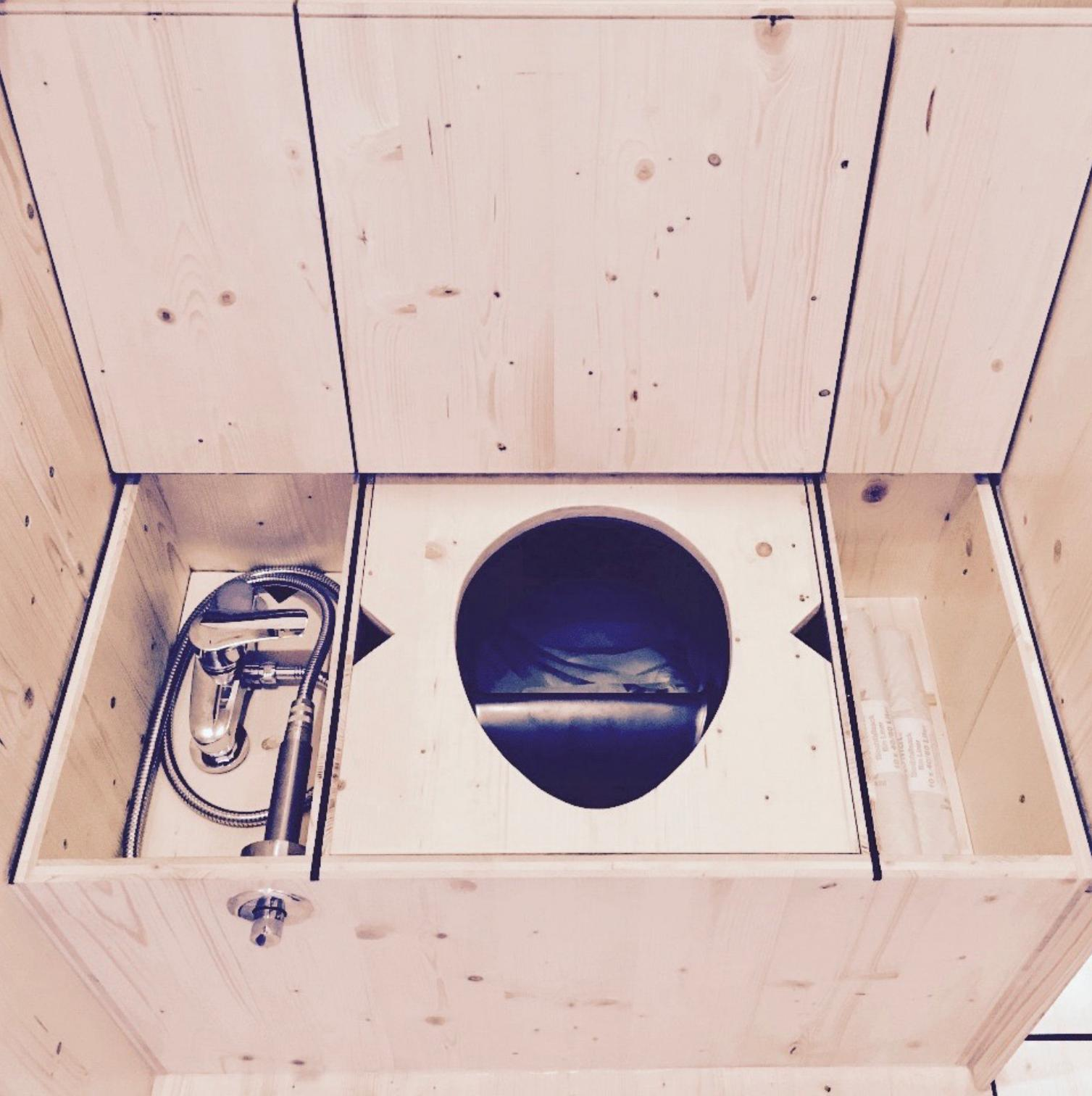
In der mittleren Unterteilung ist die Trenntoilette untergebracht. Diese besteht aus einem Trenneinsatz, einem Kübel, einem 2l Liter Kanister, kompostierbaren Säcken und einem Schlauch. Der Urinkanister ist zum Entleeren leicht zugänglich im Unterboden platziert. Unangenehme Gerüche werden durch eine Abdeckung mit Einstreu verhindert, dennoch wird regelmäßiges Entleeren empfohlen. Das Streu befindet sich im rechten Teil der Box. Zusätzlich geht von der Toilettenbox ein Abluftrohr nach Draußen.
