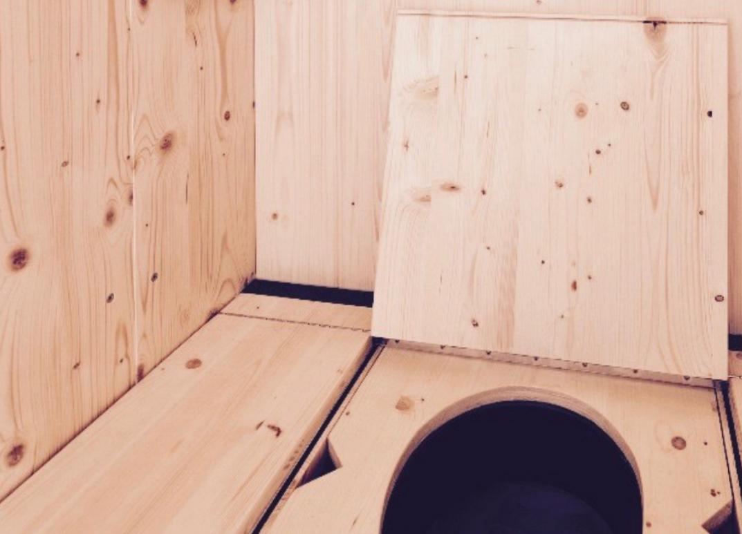
Der Sanitärbereich besteht aus einem Boxaufbau über dem bereits erhöhten Fußboden und gliedert sich in drei Teile, welche die Toilette, sowie Stauraum für das Einstreu und die Duscharmatur beinhalten.
