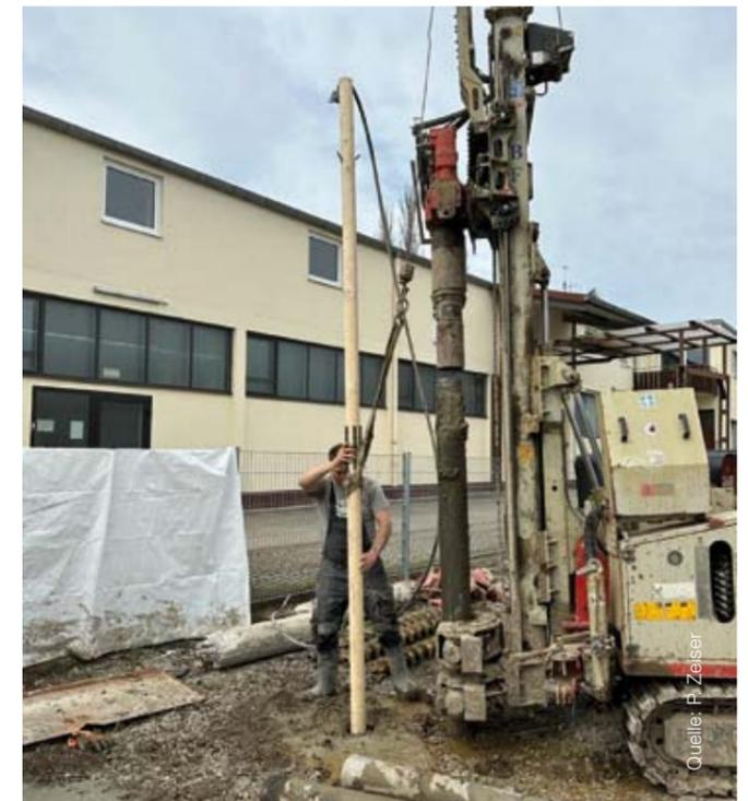
Bild 3: Einbau eines Holzpfahls mit 96 mm Durchmesser und 5000 mm Länge in verrohrter Bohrung
