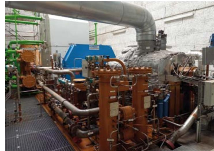
Dampfturbine, Getriebe und Generator zur Stromerzeugung
