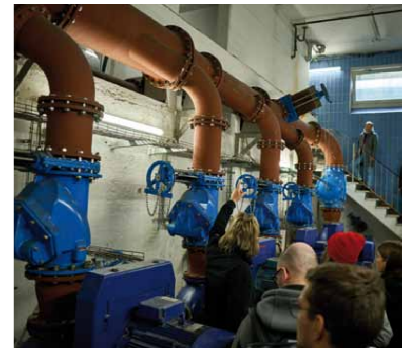
Abbildung 2 - Besichtigung Kläranlage Rosenheim
