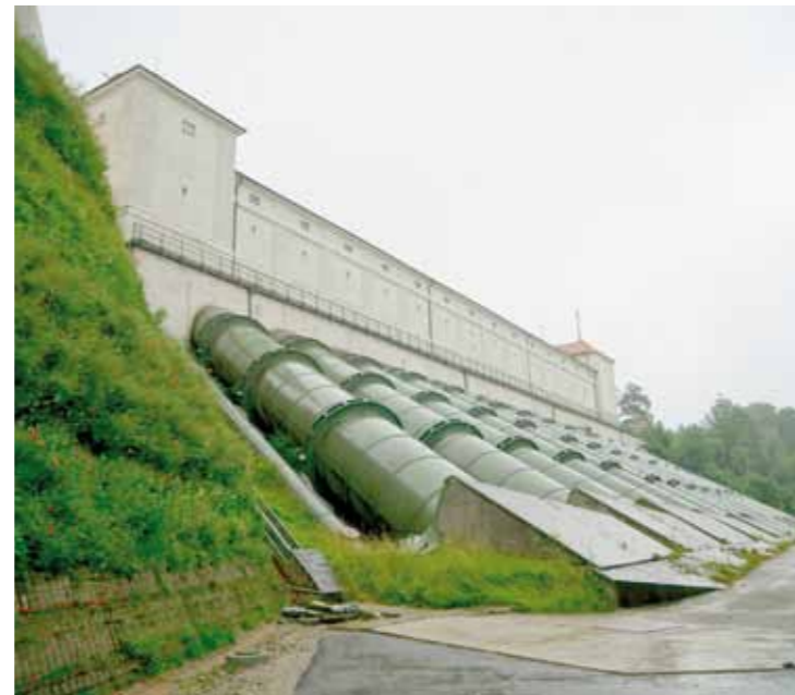
Triebleitungen des alten Kraftwerks (Foto: Neuffer)
