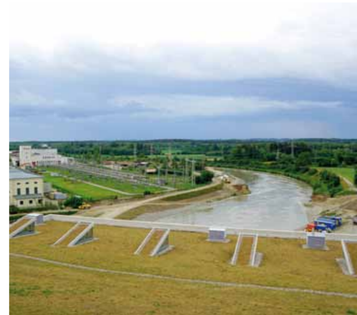
Blick vom neuen Krafthaus auf den Innkanal (Foto: Neuffer)
