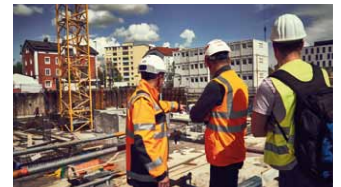
Baustellenexkursion Lokhöfe Rosenheim (Bild: Thomas Köhn)
