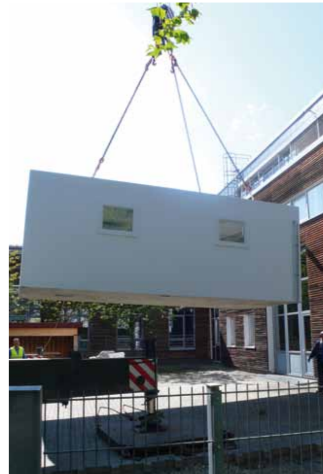
Bild 1: Aufstellen Fertiggarage Technikumsbereich Beton Labor für Baustoffe
