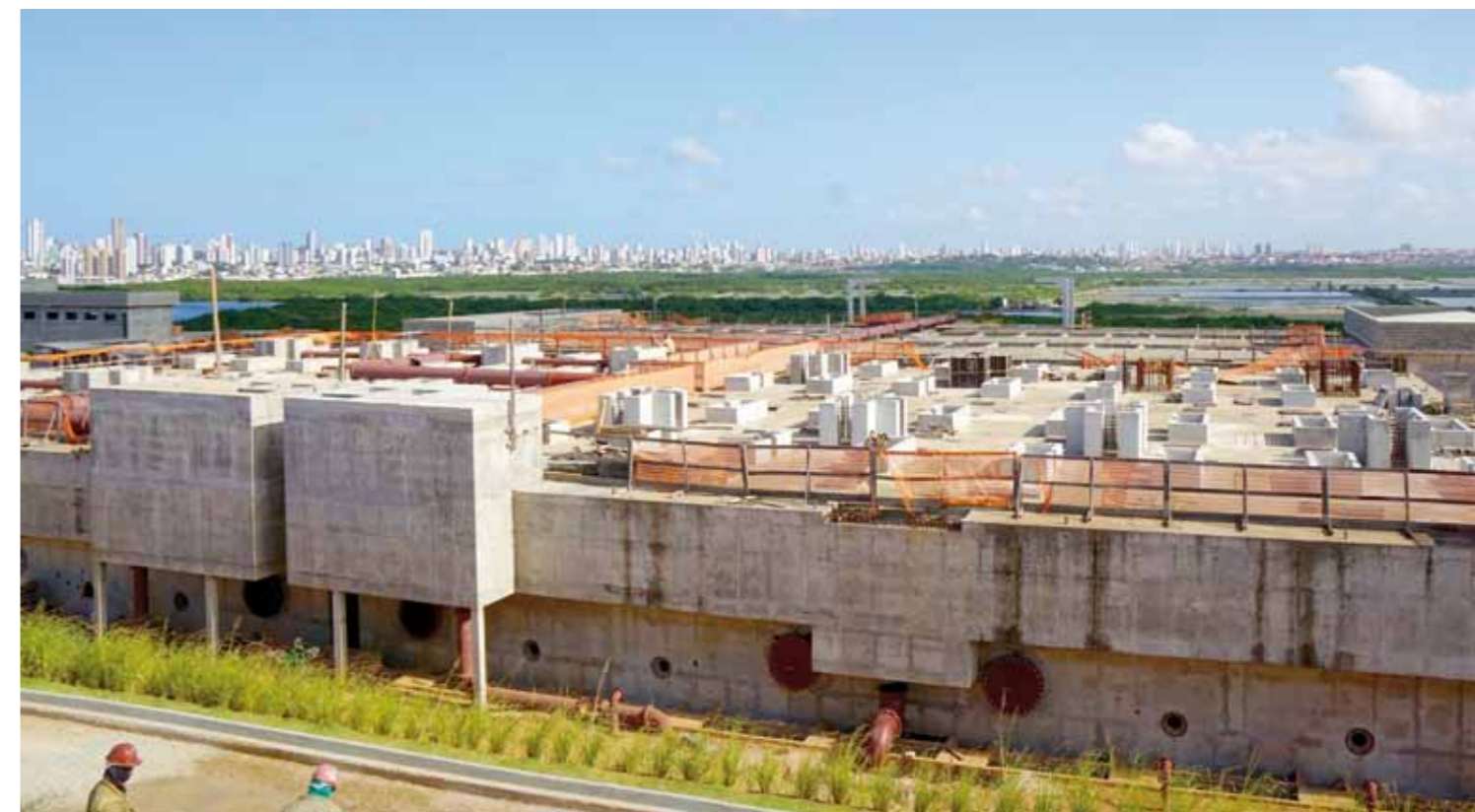
Bau einer neuen kommunalen Kläranlage für die Stadt Natal
