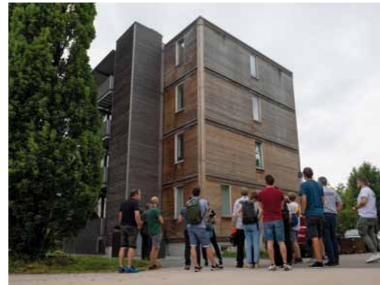
Abbildung 1: Bei dem Forschungsprojekt des „H4“ (SCHANKULA Architekten) wurde der Aufzugsschacht als ein vorgefertigtes Element montiert (Foto: Sebastian Herold).
