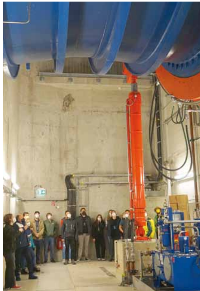
Rheinkraftwerk Iffezheim (Foto: Neuffer)
