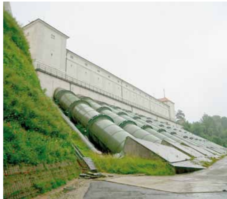
Triebleitungen des alten Kraftwerks (Foto: Neuffer)
