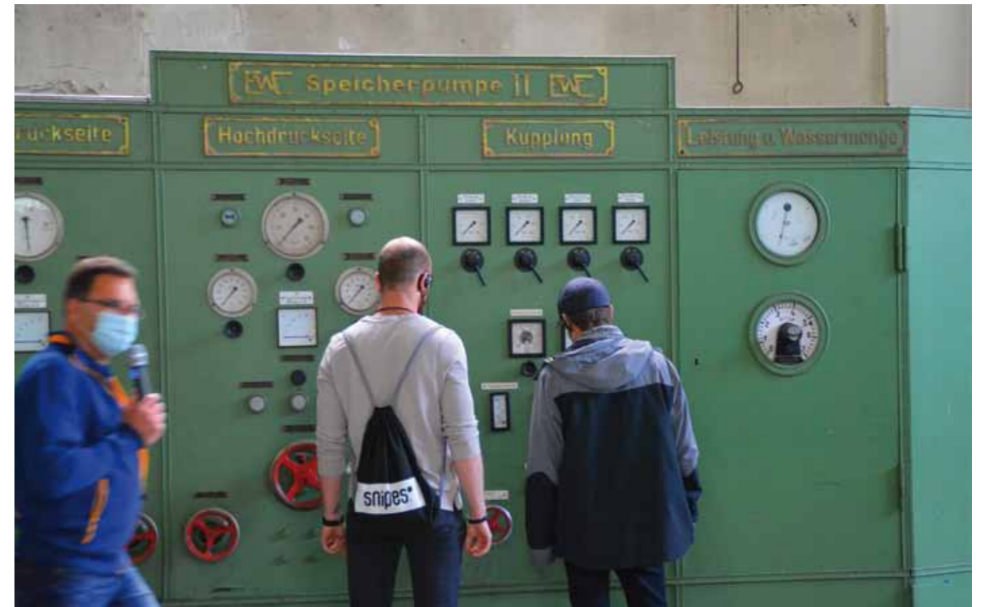
100-jährige Technik des Pumpspeicherkraftwerks in Forbach (Foto: Stengel)
