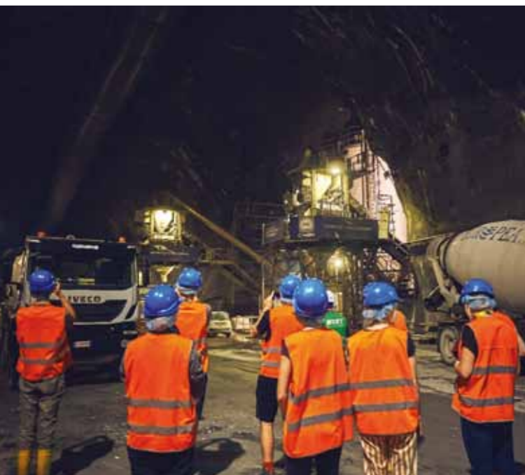
Abbildung 3 - Brenner Basis Tunnel
