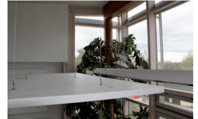
Bild 3: Trotz großer Abmessungen sind die Segel leicht, eine Befestigung durch sechs eindrehbare Spiralelemente genügt
