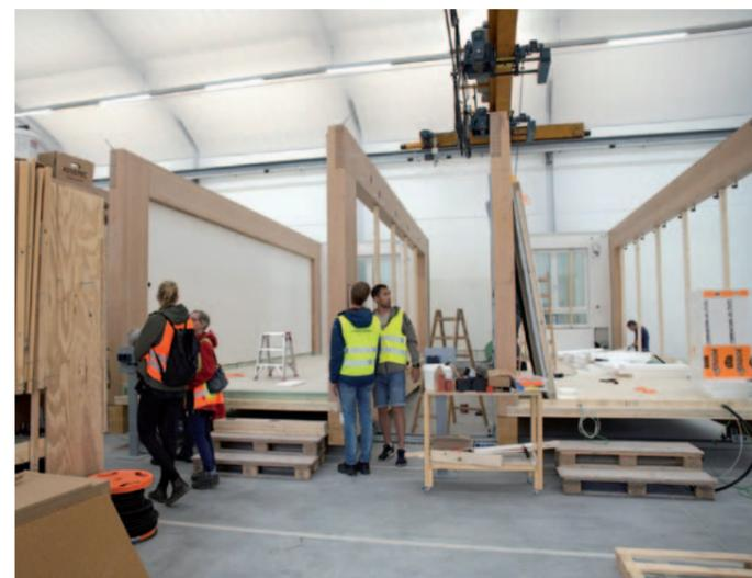
Bild 3: Auf die Rohbau-Fertigung folgt der Einbau des Fußbodens
