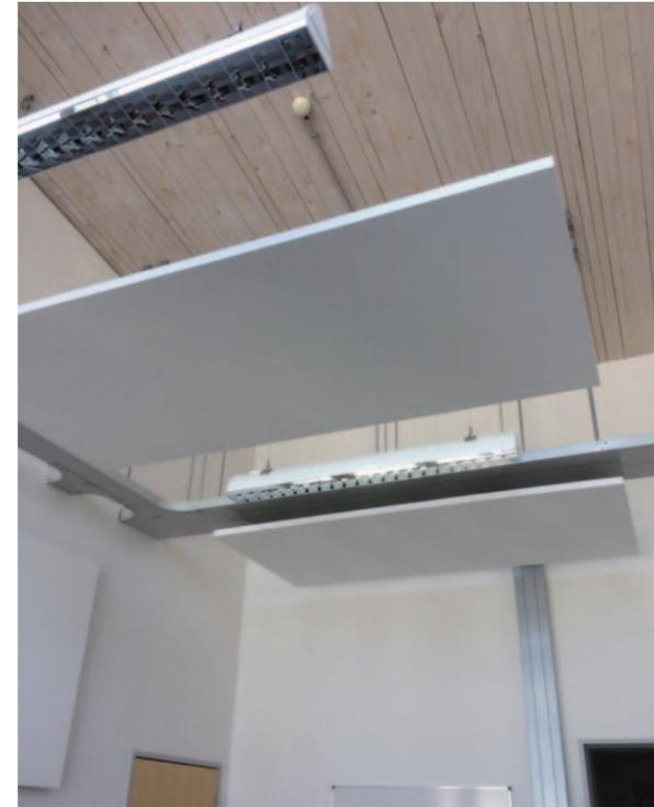
Bild 1: Pilotbüro S 2.16: Zwei Deckensegel auf Höhe der Pendelleuchten, links teilweise sichtbar der Wandabsorber
