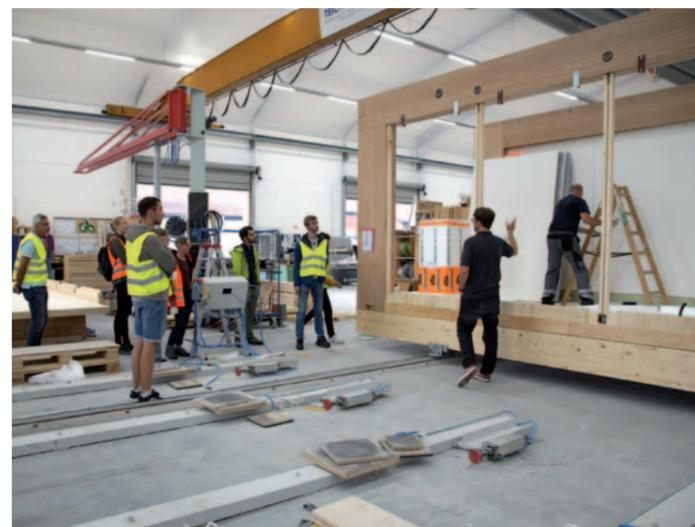
Bild 2: Betriebsleiter Urs Ickler (2. v. rechts) erläutert die Montage an einem „Gewerbemodul“ mit einer geschlossenen Seite (Hintergrund) und einer offenen Seite (Vordergrund) mit Baubuche-Rahmen.
