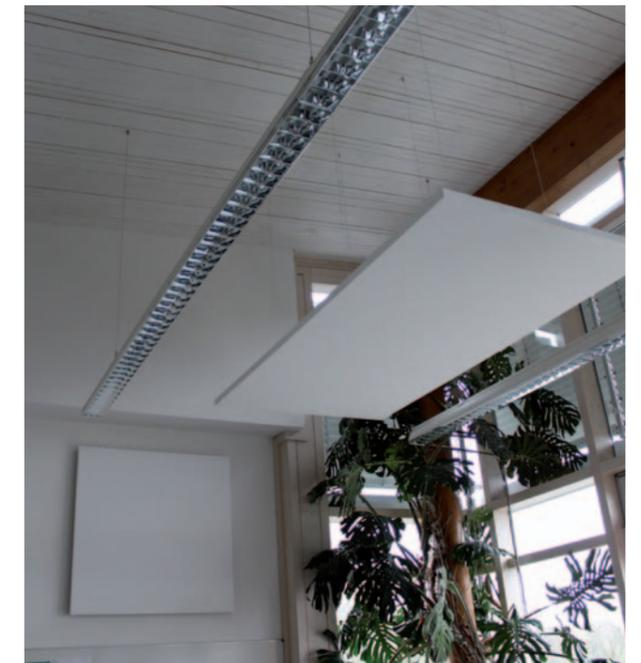
Bild 4: Erst die Wand- und Deckenabsorber, hier in einem Mitarbeiterbüro, ermöglichen die für kleine Mehrpersonbüros empfohlene Raumakustikklasse B nach VDI 2569
