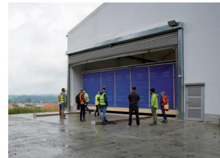
Bild 4: Die fertigen Module verlassen die Produktionshalle zur Verladung
