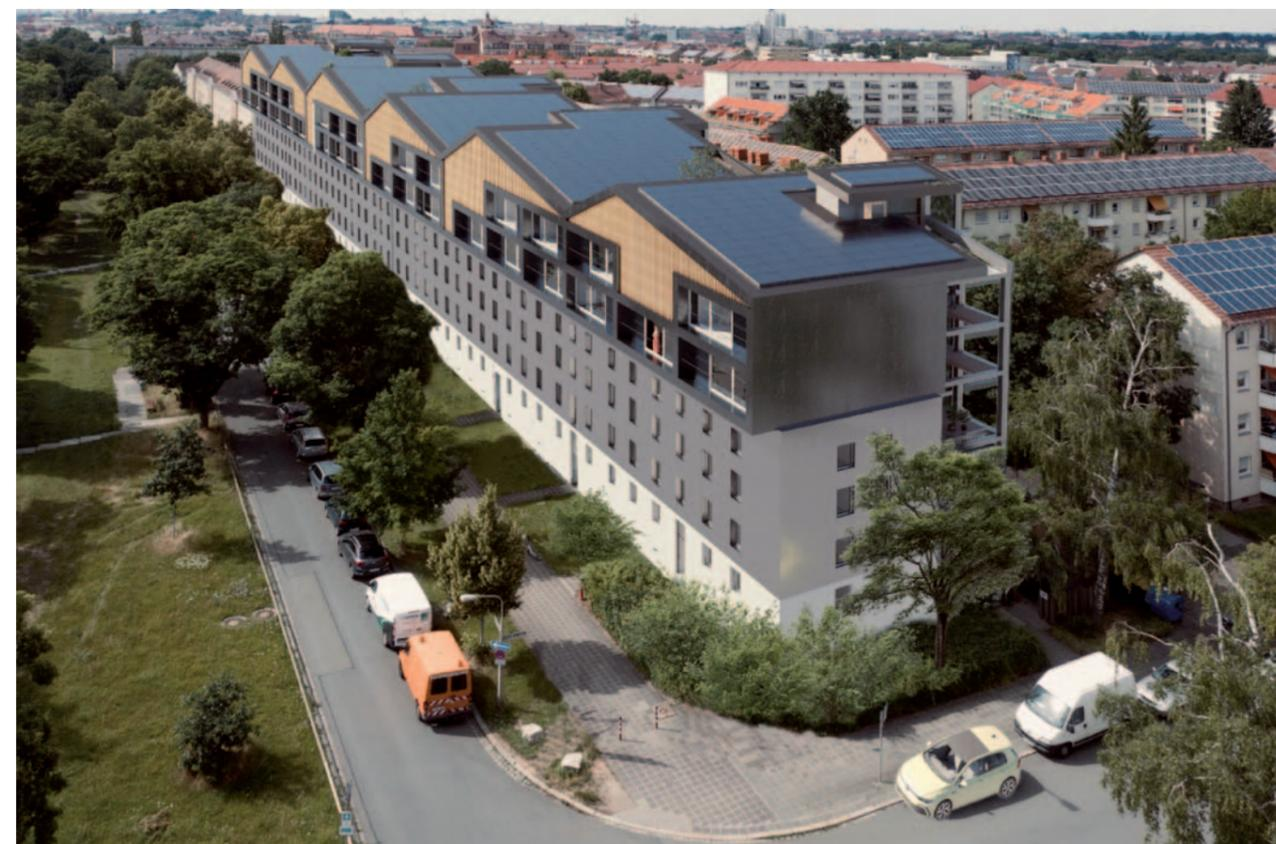
Das Rosenheimer Team entwickelt für ein Gebäude in Nürnberg eine modulare und adaptierbare Aufstockung in Holz-Modulbauweise. Das levelup-System kann auf verschiedene Gebäudelängen und -breiten reagieren und daher auch auf andere Gebäude der 1950er – 70er Jahre angewendet werden, dem größten Gebäudebestand in Deutschland.
