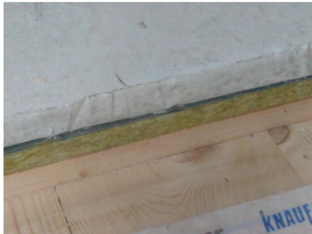
**Abbildung 7.16:** Reale Struktur Fließestrich
