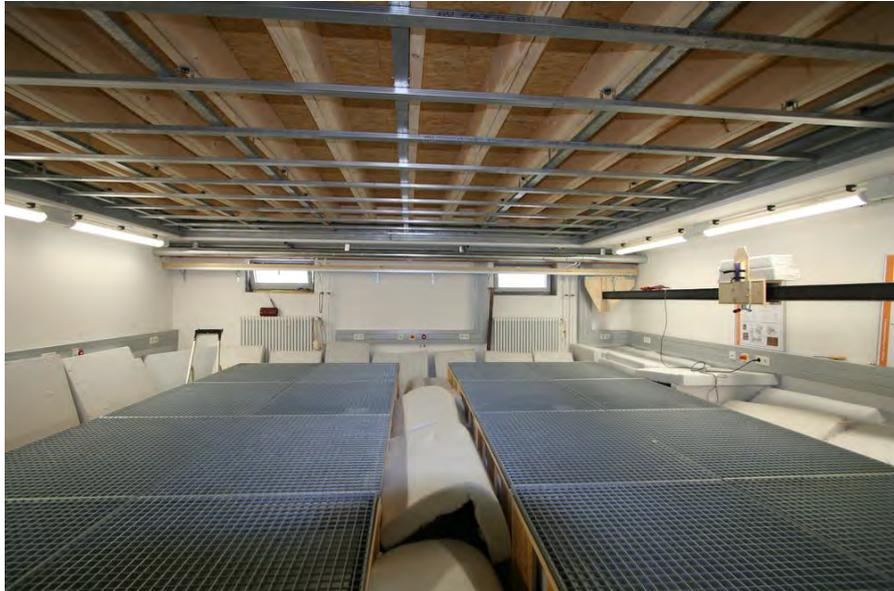
**Abbildung 2.11:** Unterkonstruktion der Unterdecke befestigt an Holzbalkendecke
