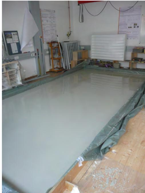
**Abbildung 2.15:** Fließestrich unmittelbar nach dem Einbringen
